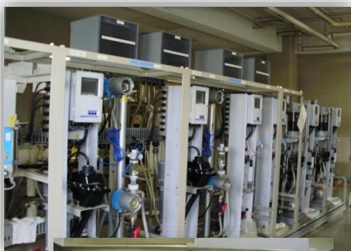
坂口浄水場 水質計器室
