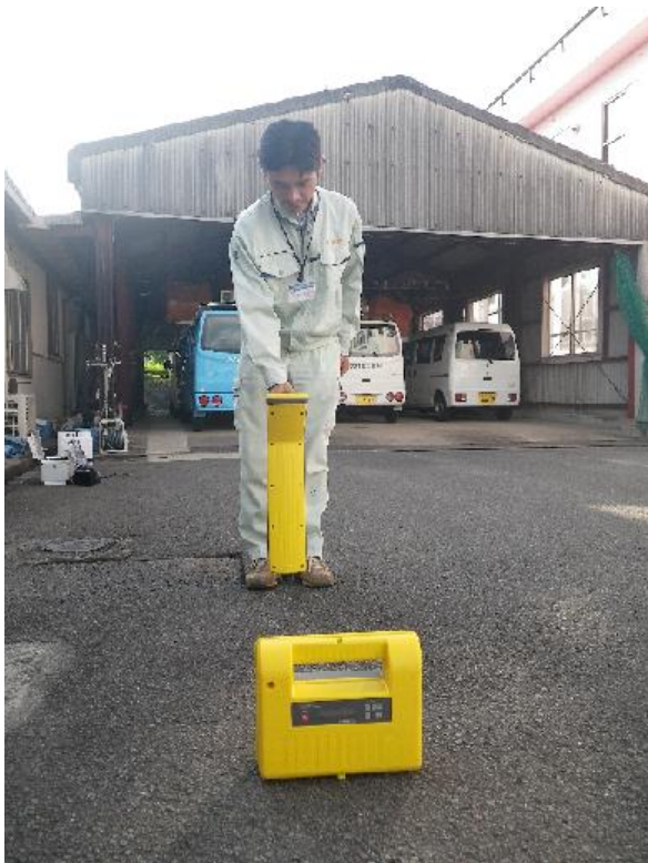
管路探知機による探査の様子
