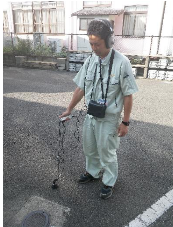
漏水探知機による漏水調査
