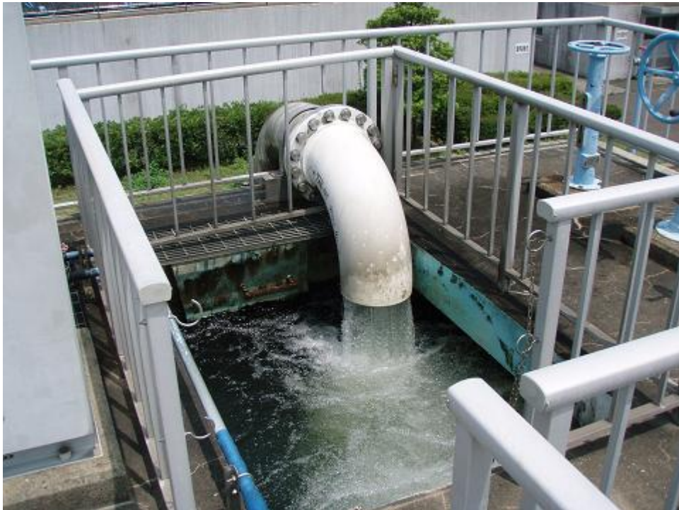
着水井（坂口浄水場）
