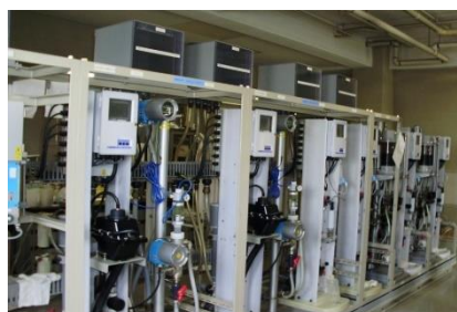
坂口浄水場 水質計器室
