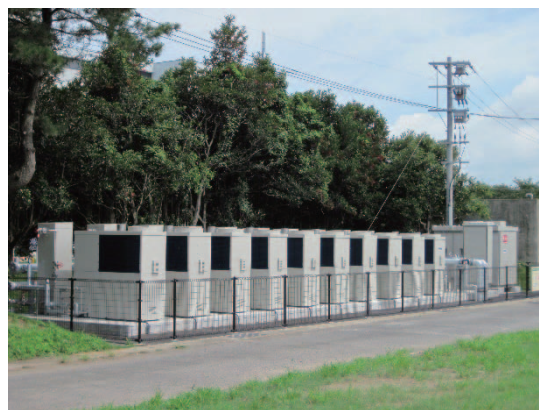
写真 5.5 消化ガス発電設備
