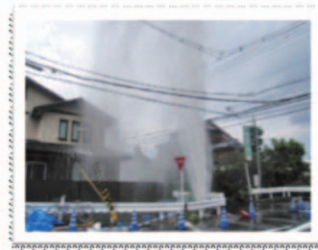
他市の漏水事故
