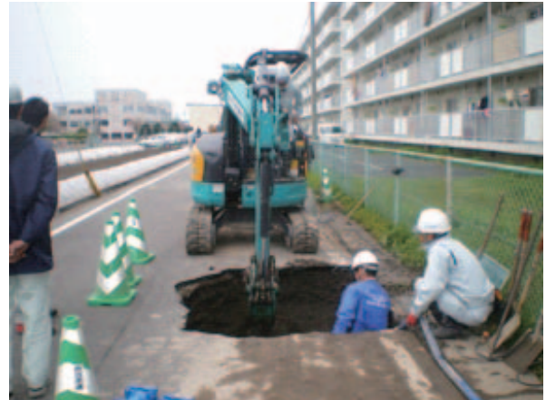
写真 9.4 漏水修繕の状況
