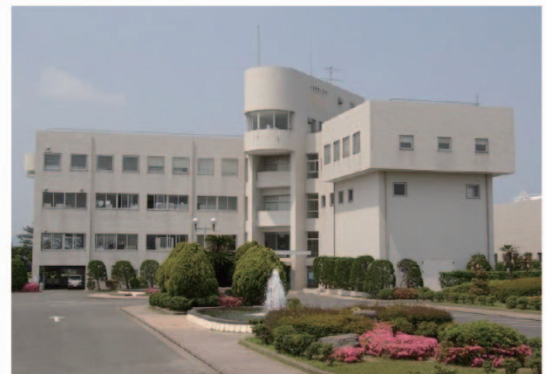
写真 2.1 大村浄水管理センター管理本館
