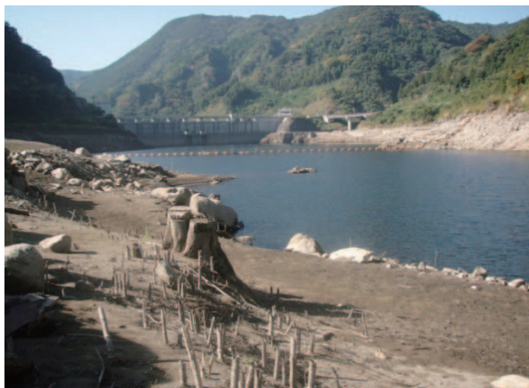
写真 9.1 渇水状況（平成 19 年 11 月撮影）
