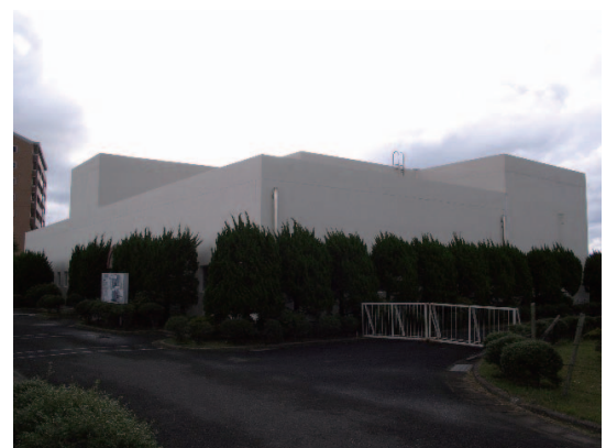
写真 2.2 大村ポンプ場
