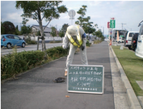
写真 9.3 漏水調査の状況
