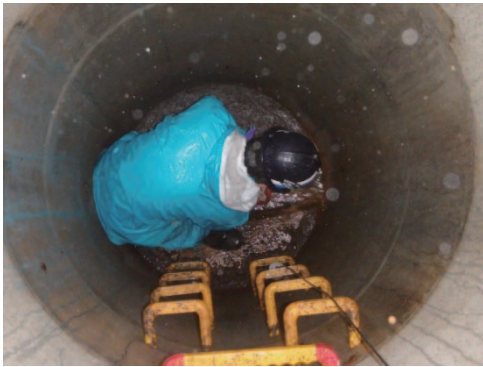
写真 9.3 不明水調査状況
