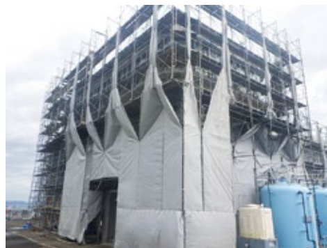
坂口浄水場耐震補強工事
