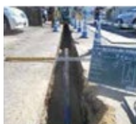
管路更新状況
