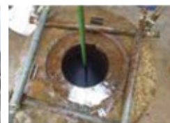
井戸改修状況
