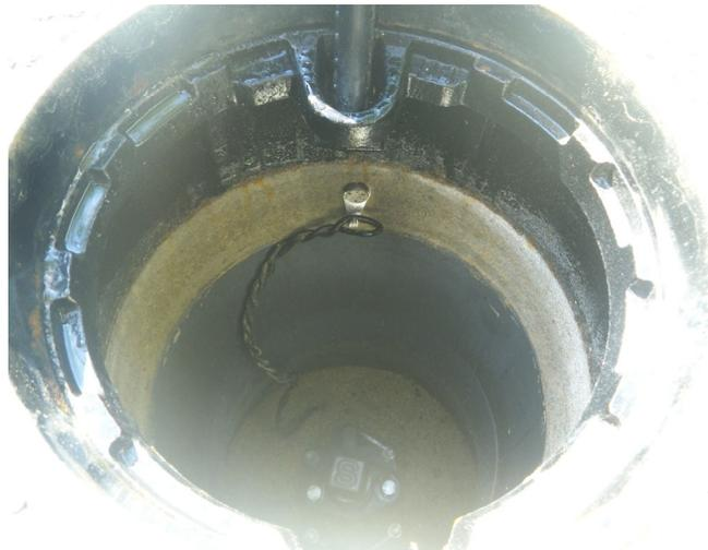
参考(仕切弁BOX蝶番下ハイジャスター部にコンクリート部専用フックを取り付けた事例)
