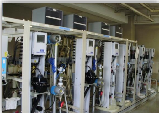
坂口浄水場 水質計器室
