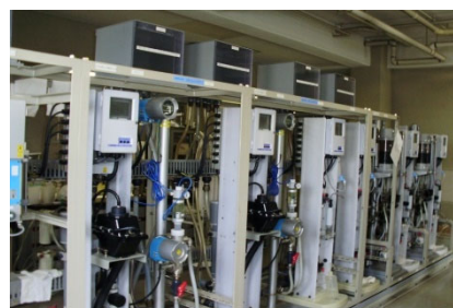
坂口浄水場 水質計器室
