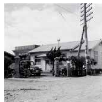
昭和46年水道庁舎 (現局舎敷地)
