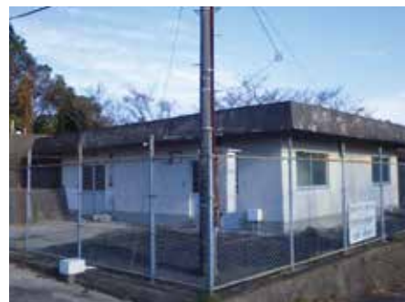
大多武浄水場
