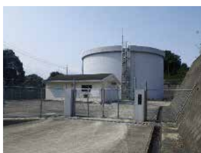
徳泉川内配水池
