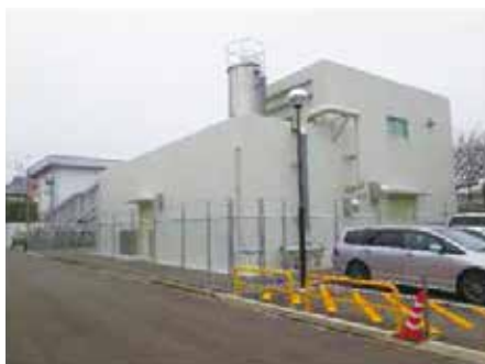
杭出津浄水場
