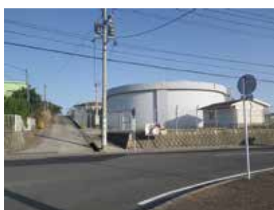
雄ヶ原配水池
