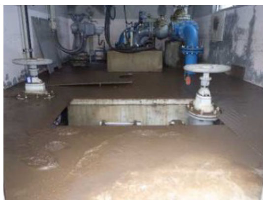
今富水源浸水状況(R2)
