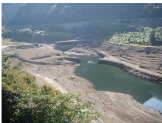
萱瀬ダム渇水状況(H19)
