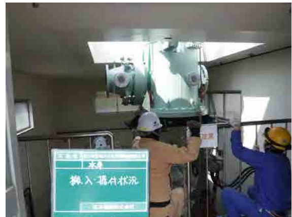
搬入・据付中
