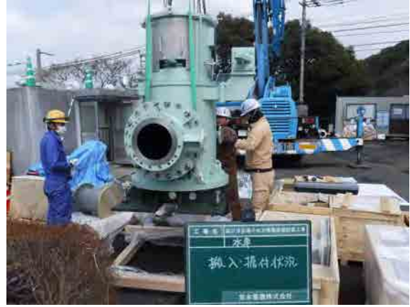
搬入・据付中
