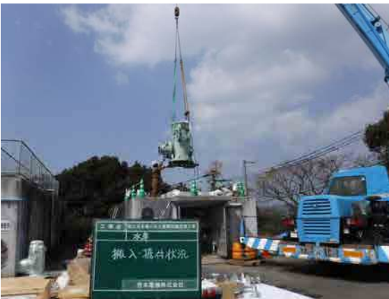
搬入・据付中
