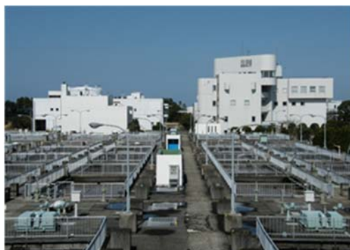
写真2.1 大村浄水管理センター処理施設
