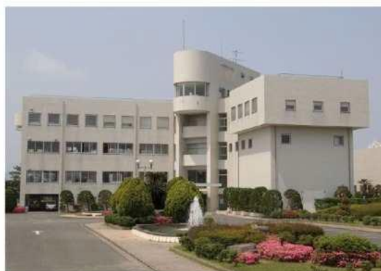
【写真】大村浄水管理センター管理本館
