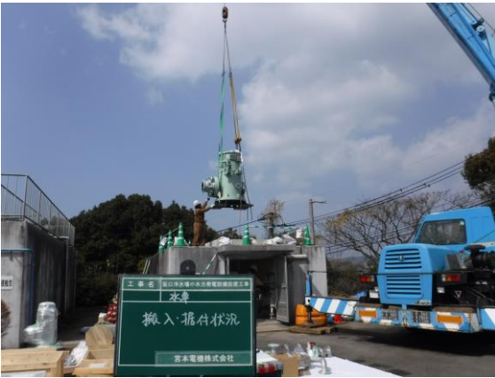
搬入・据付中
