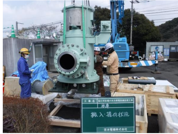
搬入・据付中
