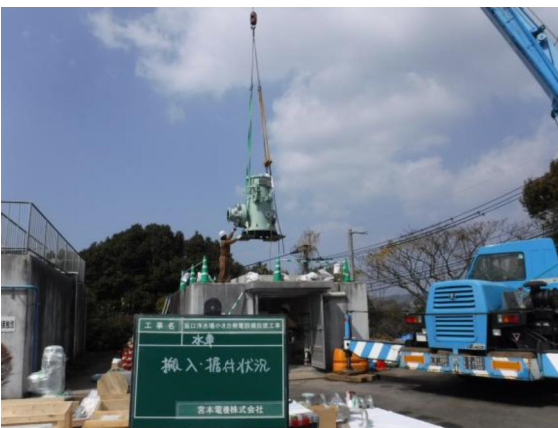
搬入・据付中
