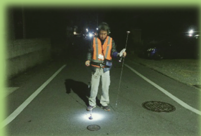
調査状況(夜間)
