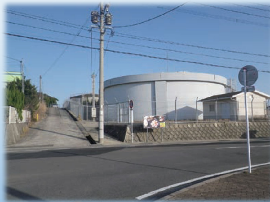
雄ヶ原配水池
