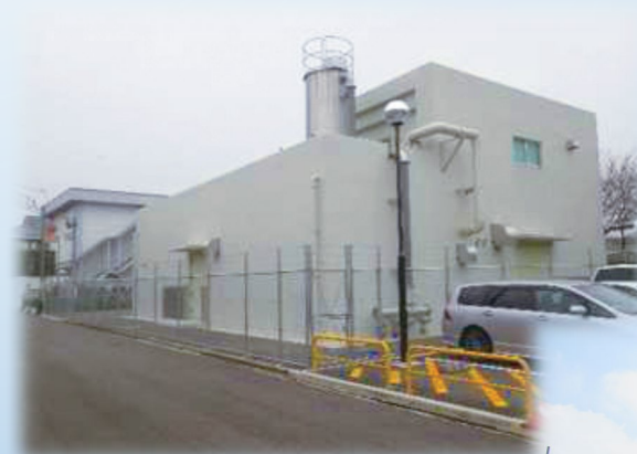
杭出津浄水場
