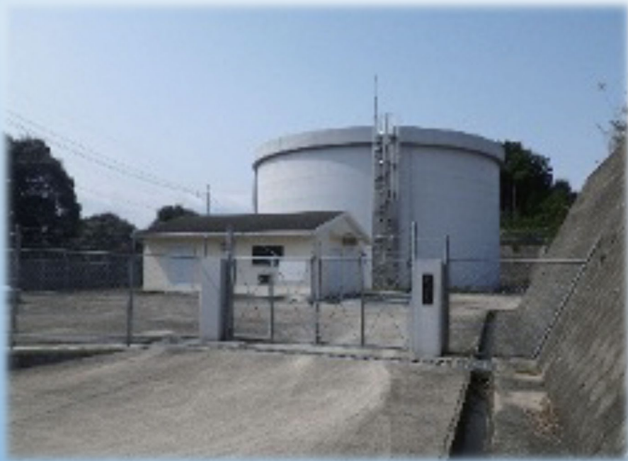
徳泉川内配水池
