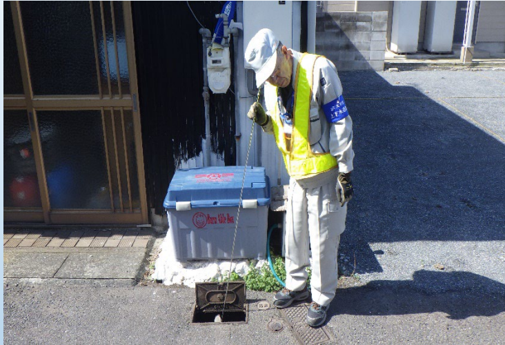
漏水調査を行っている様子
