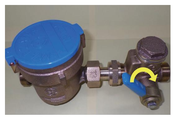
メーターBOX内のレバーをメーターの反対側に倒すと水が止まります。
